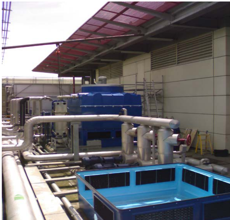
Montaj instalatie turn de racire EWK si schimbatoare de caldura Alfa Laval
